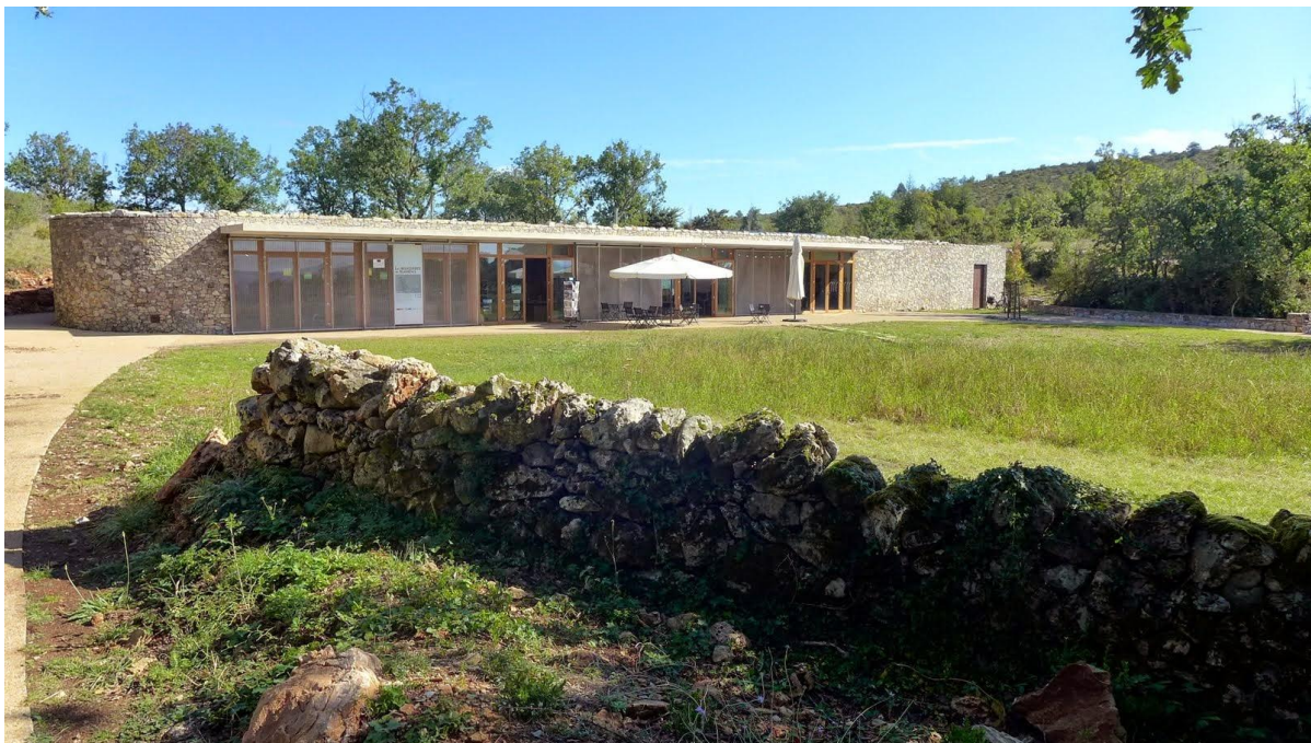
Maison de Site des Belvédères de Blandas
